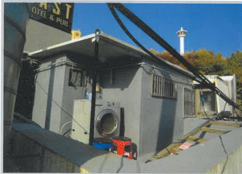
제시외건물 기호㉠ 전경
