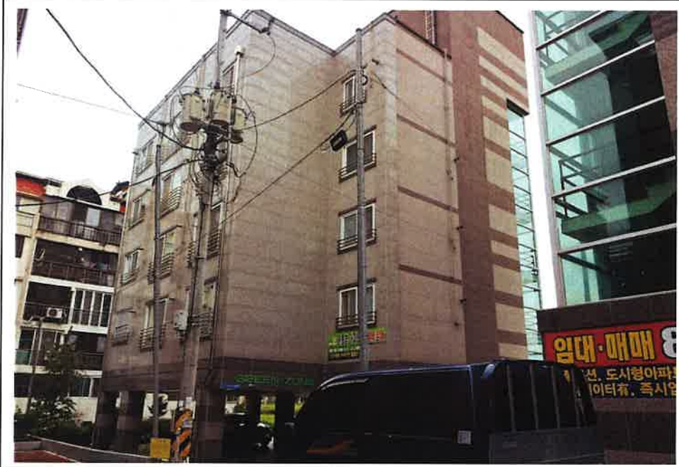
본건 전경(남동측에서 촬영)
