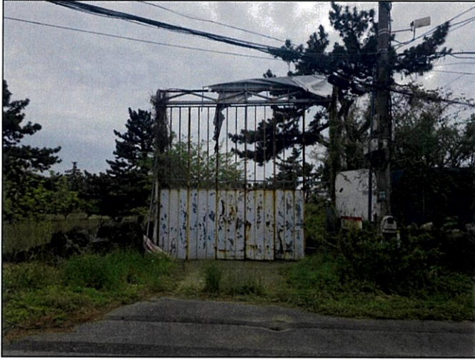
본건 출입문 전경
