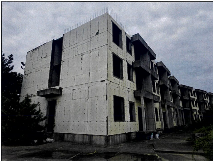
본건 기호(1 ~ 3) 위 지상 소재 공사 중단 건축물
