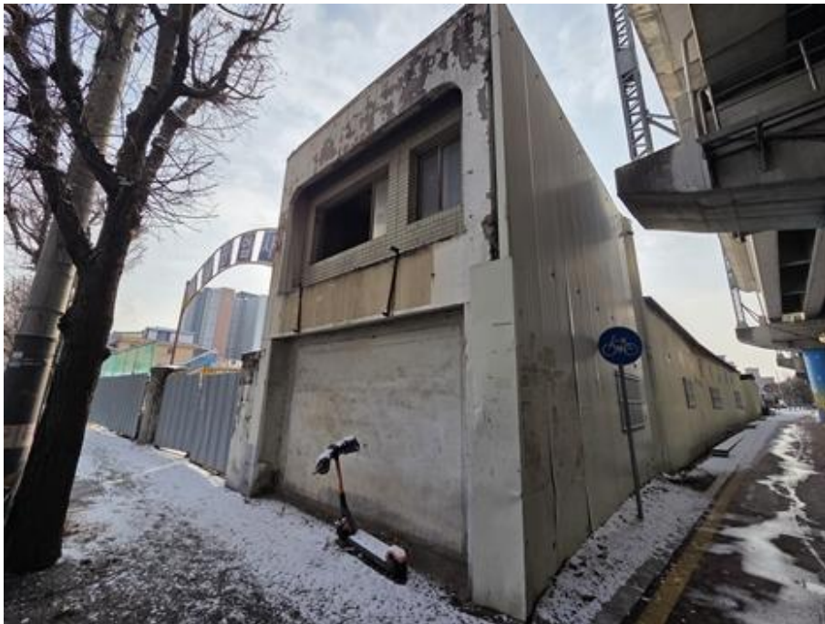
대상토지 기호(4),(5) 및 대상건물 기호(라) 전경
