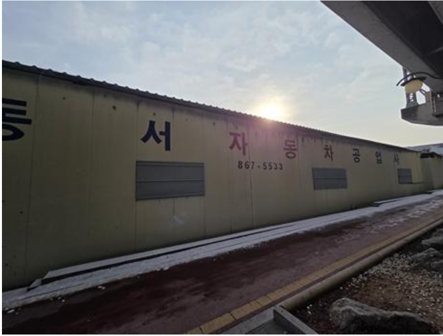
대상건물 기호(다) 전경
